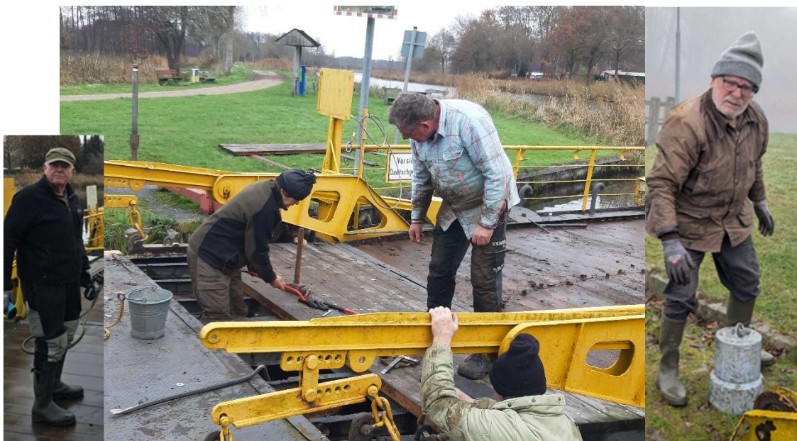
Foto: Demontage der Decksbohlen im Dezember 2025
